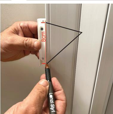
Acerque el bloque al soporte del mango, imán, colocándolo a una altura de unos 110 cm del suelo. Haz 2 marcas donde vendrá hizo el corte.
