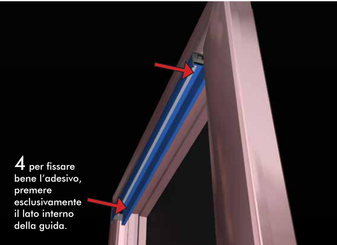
**4** per fissare bene l'adesivo, premere esclusivamente il lato interno della guida.
