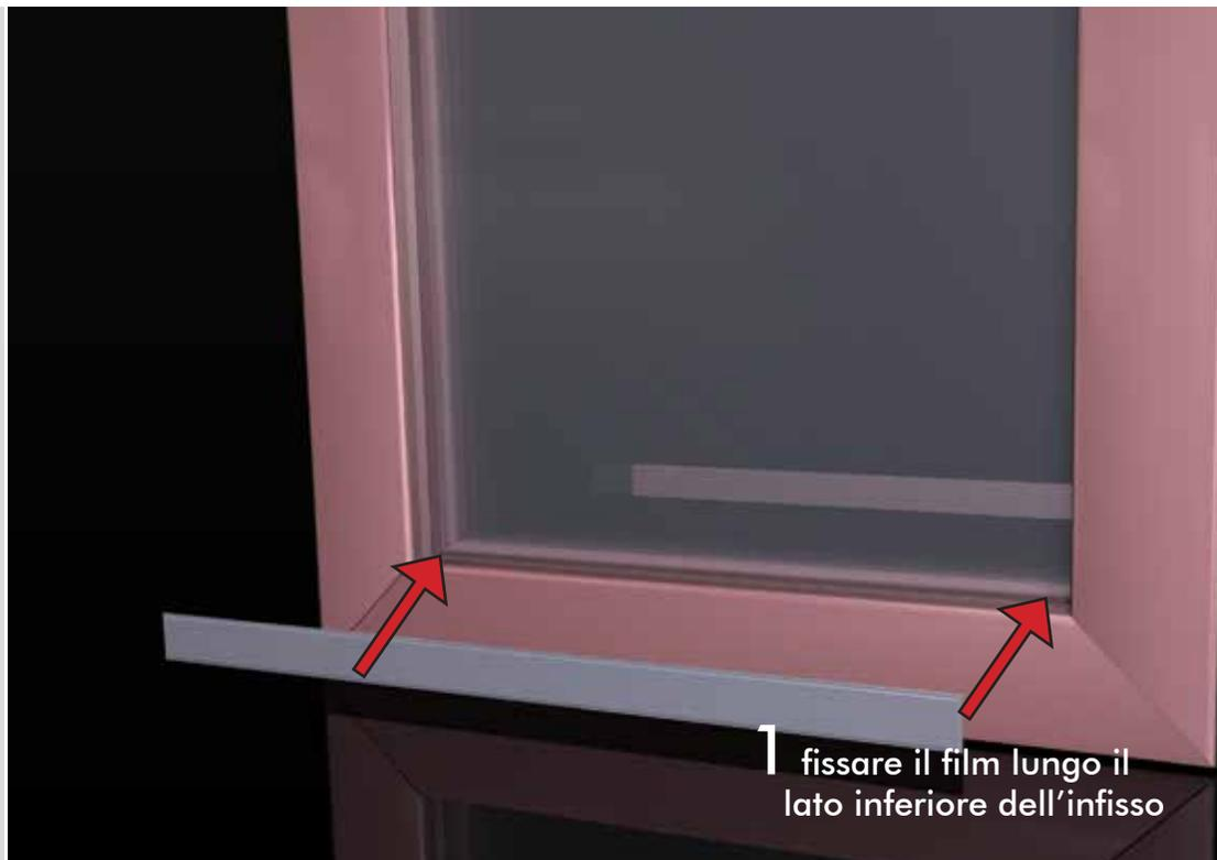
**1** fissare il film lungo il lato inferiore dell'infisso
